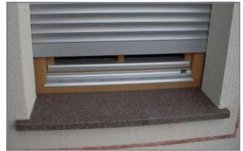
Fensterbänke aus Naturstein können im Innen- und Außenbereich angebracht werden. Sie sind pflegeleicht und unempfindlich. Erhältlich mit geflammter, polierter oder gebürsteter Oberfläche. Sie werden auf Maß zugeschnitten, die Stärke ist ca. 3 cm.
