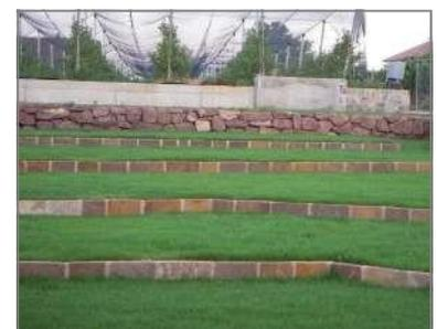
Im Gartenbau finden Randsteine aus Porphyr vor allem als dekorative Einfassungen von Grünanlagen ihren Einsatz. Sie sind in den Standardbreiten 8-15 cm und mit einer Höhe von 20-30 cm erhältlich. Die Längen sind frei, die Oberfläche bruchrau, geflammt oder gestockt. Die Sichtkante
