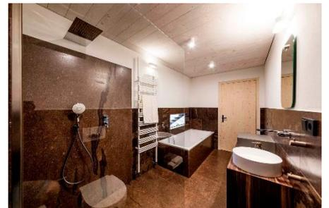
Die gebürstete oder satinierte Oberfläche ist ein pflegeleichter Bodenbelag und Wandverkleidung im Innenbereich. Auch hier sieht man die violette Maserung, die naturbedingt mal stärker mal schwächer ausgeprägt ist. Bei einer Bodenheizung ist Naturstein der ideale Belag, da er ein sehr guter Wärmespeicher ist. Die Stärke der Platten ist 2 oder 3 cm, die Breite 20-25-30-40-50 cm, die Länge laufend. Auf Anfrage liefern wir natürlich auch Platten mit fixen Maßen.
