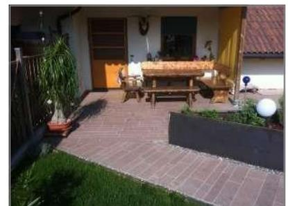
Die gesägte und geflammte Oberfläche ist ebenfalls für den Außenbereich geeignet. Bei dieser Art von Bearbeitung kommen die für den Montiggler Porphyre charakteristischen violetten Maserungen besonders gut zur Geltung. Diese Einschüsse sind naturbedingt mal stärker mal schwächer ausgeprägt. Die Stärke der Platten ist 2,3 oder 4 cm, die Breiten 20-25-30 cm, Länge laufend oder fix.
