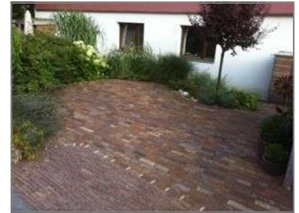
Die Binder- oder Begrenzungssteine aus Porphyr mit bruchrauh Oberfläche werden zur Einfassung von Gärten, Beeten, Gehwegen, usw. verwendet. Genauso eignen sie sich aber auch als Bodenbelag bei Einfahrten und Plätzen. Sie sind in den Maßen 10 x 8/10 x 20/30 cm oder 12 x 10/12 x 20/40 cm erhältlich. 15 cm Breite auf Anfrage erhältlich
