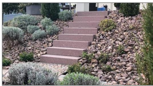
Ein sehr beliebtes Gestaltungsmaterial im Außenbereich sind massive Blockstufen aus Porphyrt. Sie sind in verschiedenen Größen und Ausführungen erhältlich (ca. 80-100 x 35 x 15-17 cm). Sie können naturbelassen oder auf Maß gesägt und geflammt sein.
