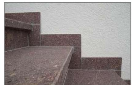
Kehrleisten aus Montiggler Porphyrsind stabil und bilden einen eleganten Abschluss zu Ihrem Boden. Sie sind poliert, geflammt oder geflammt-gebürstet erhältlich und können entweder flächenbündig eingesetzt oder mit abgerundeter Kante aufgesetzt werden. Die Höhe der Kehrleisten ist 8 oder 10 cm, die Dicke 1 bis 1,5 cm. Die Längen sind frei.
