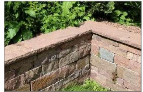
Abdeckplatten aus Porphyrdienen als dekorativer Schutz für Mauern usw. Sie haben eine bruchraue Naturoberfläche oder sind geflammt. Die Stärke ist ca. 4 cm, die Breite bis zu 40 cm, die Länge ist laufend. Die Kanten sind gehackt oder ges und geflammt.
