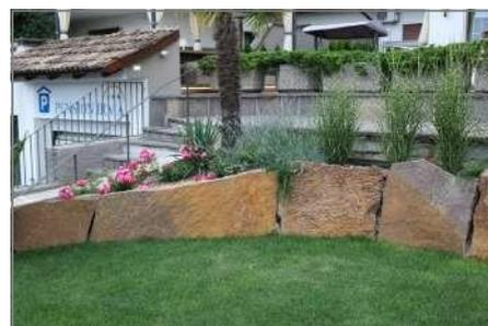
Zyklopenplatten sind ein beliebtes Gestaltungsdetail im Gartenbau. Sie dienen zum Abstützen und Abgrenzen von erhöhten Flächen. Sehr dekorativ mit naturbelassener Oberfläche. Die Stärken gehen von 8 bis 15 cm. Die Größen sind variabel.
